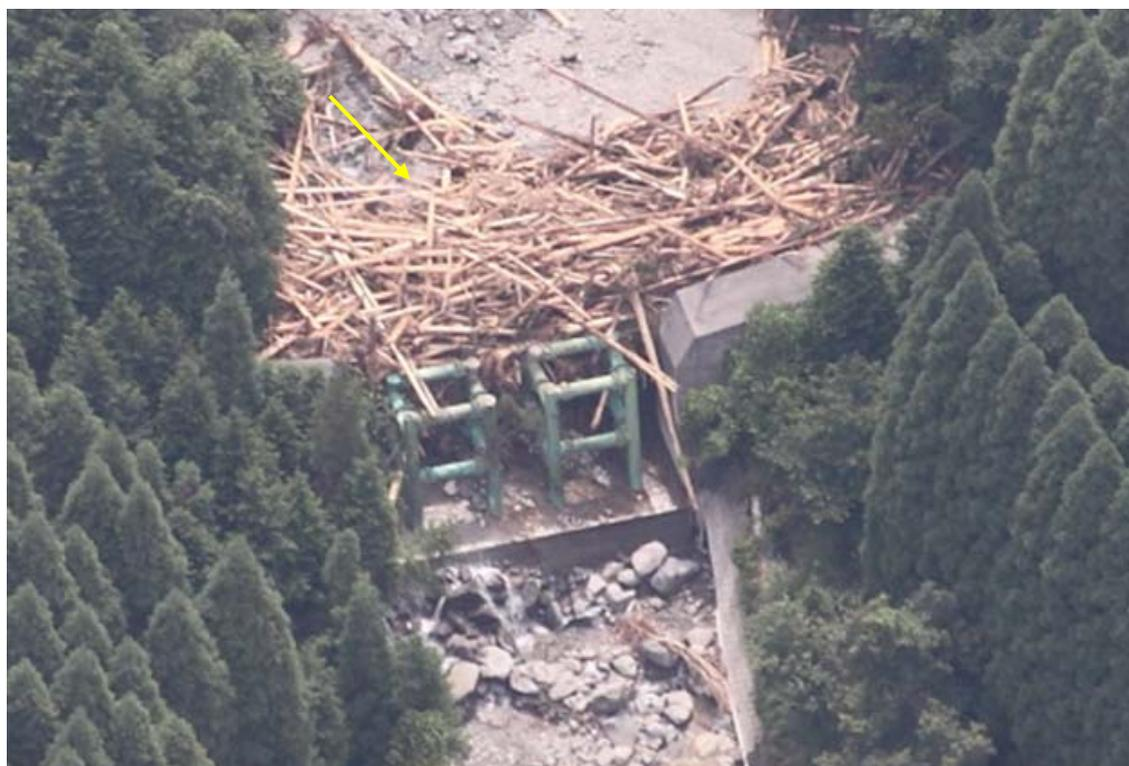
田良川砂防堰堤の土石流捕捉状況（中津市山国町草本）
