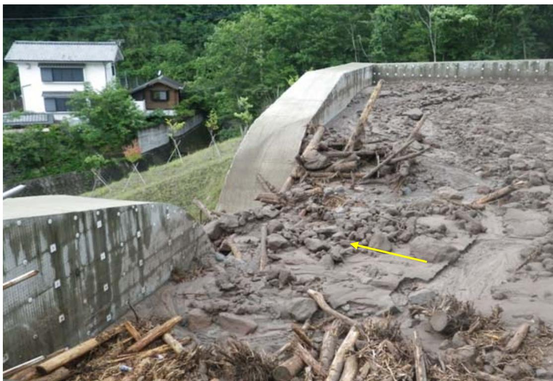
所小野川砂防堰堤の土石流捕捉状況（中津市山国町小屋川）
