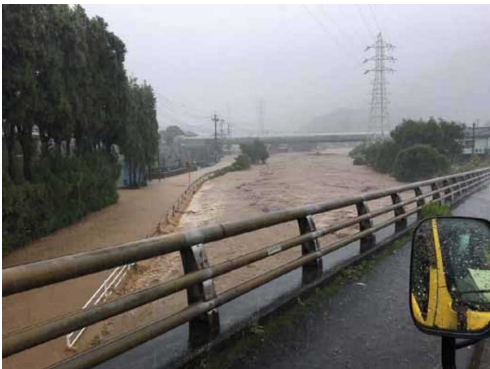
青江川出水状況（津久見市中町）【台風第18号】
