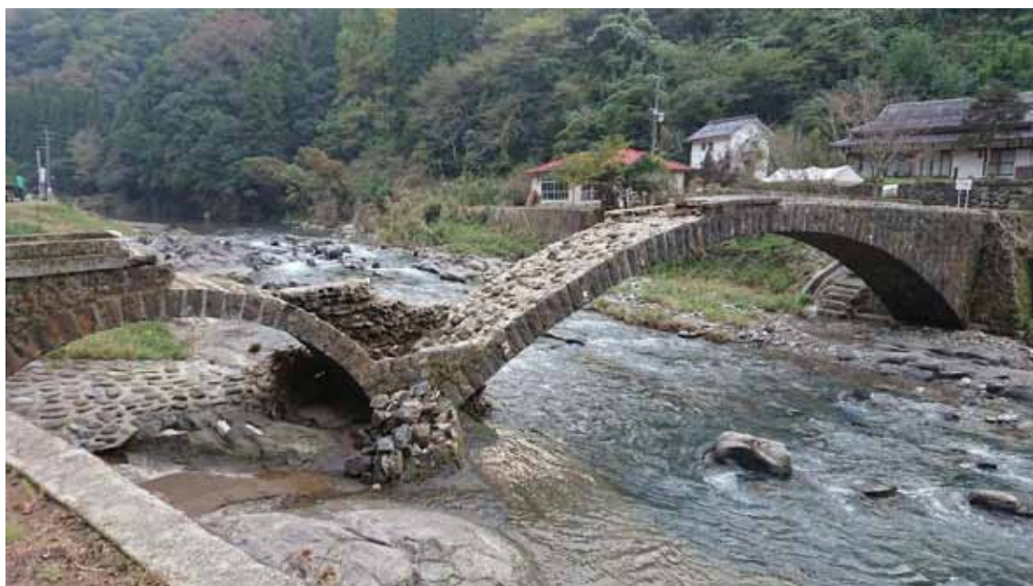
奥岳川（中津無礼川）石橋被災状況（豊後大野市三重町内平）【台風第18号】
