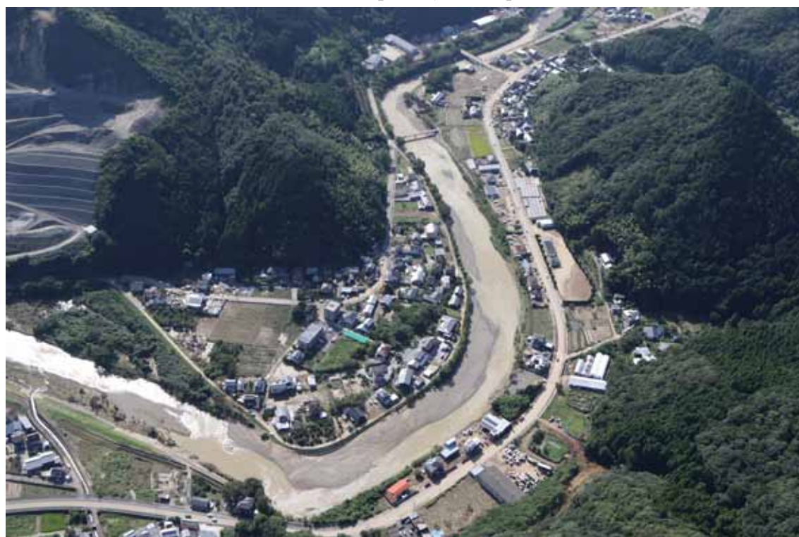
井崎川（元田・稽古屋地区）【台風第18号】
