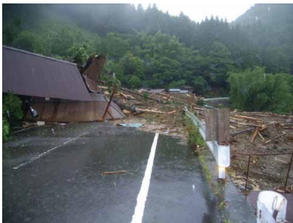
国道496号被災状況（中津市山国町草本）【九州北部豪雨】
