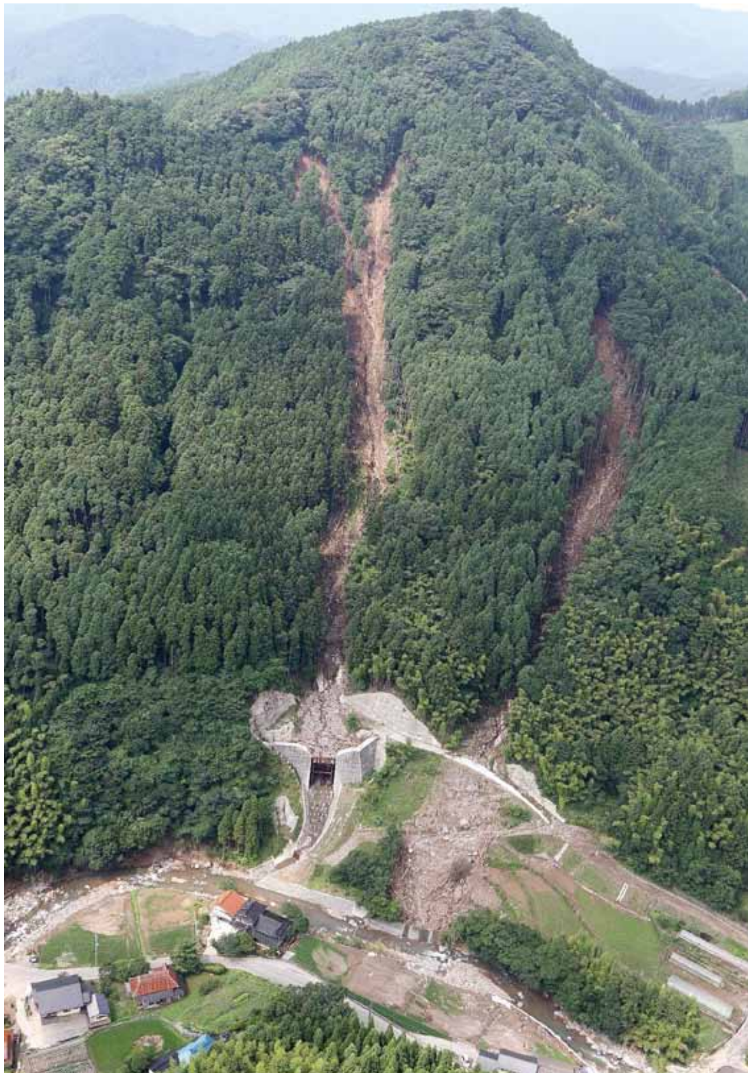
柚ノ木川土石流被災状況（日田市大字鶴河内）【九州北部豪雨】
