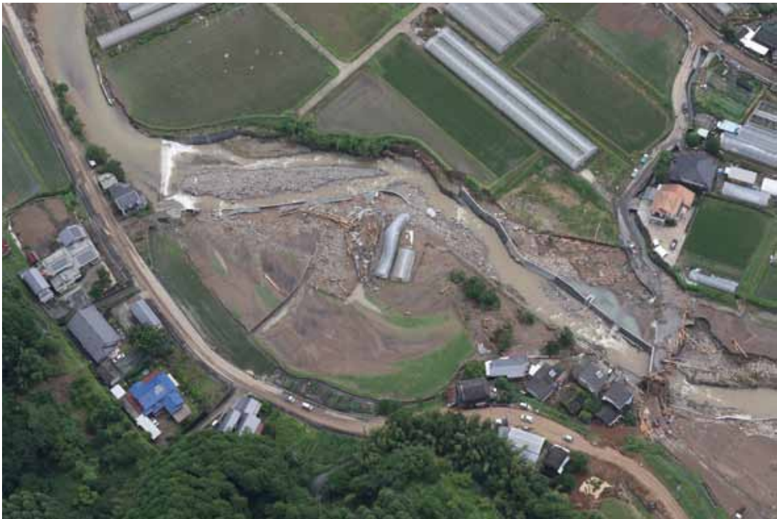
鶴河内川（日田市大字鶴河内）【九州北部豪雨】
