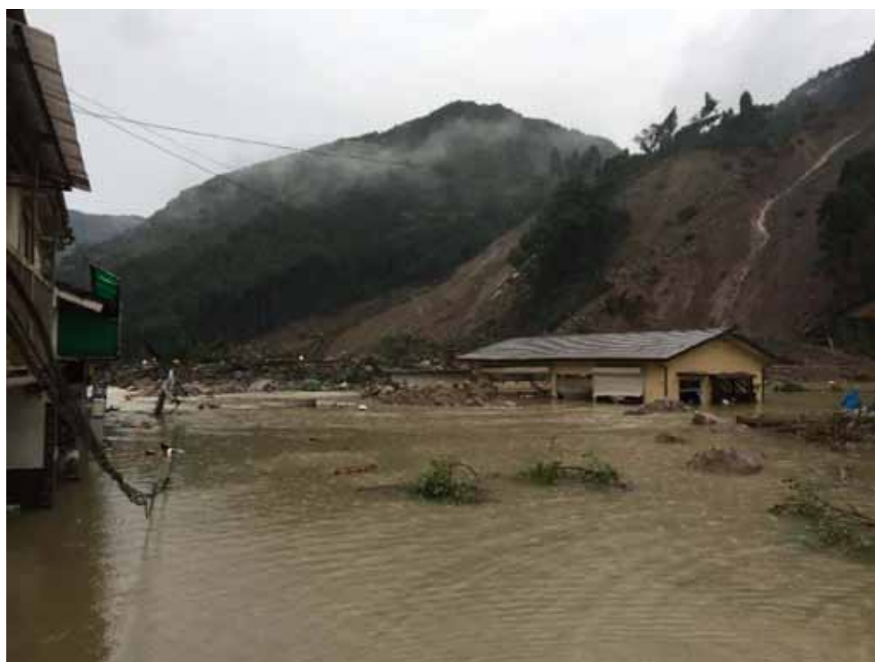
小野川出水状況（日田市大字小野）【九州北部豪雨】
