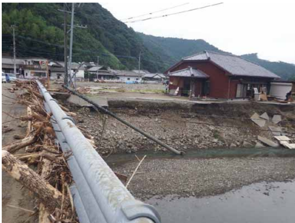
井崎川被災状況（佐伯市弥生大字大坂本 元田橋付近）【台風第18号】
