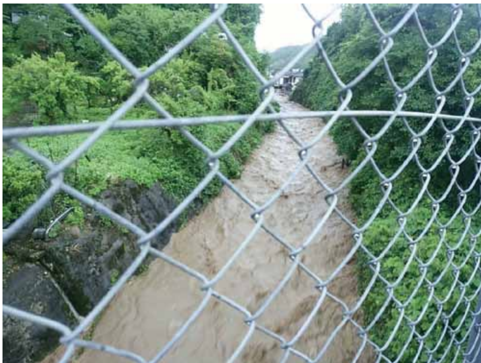
大肥川出水状況（日田市大字大肥） J R 日田彦山線 【九州北部豪雨】
