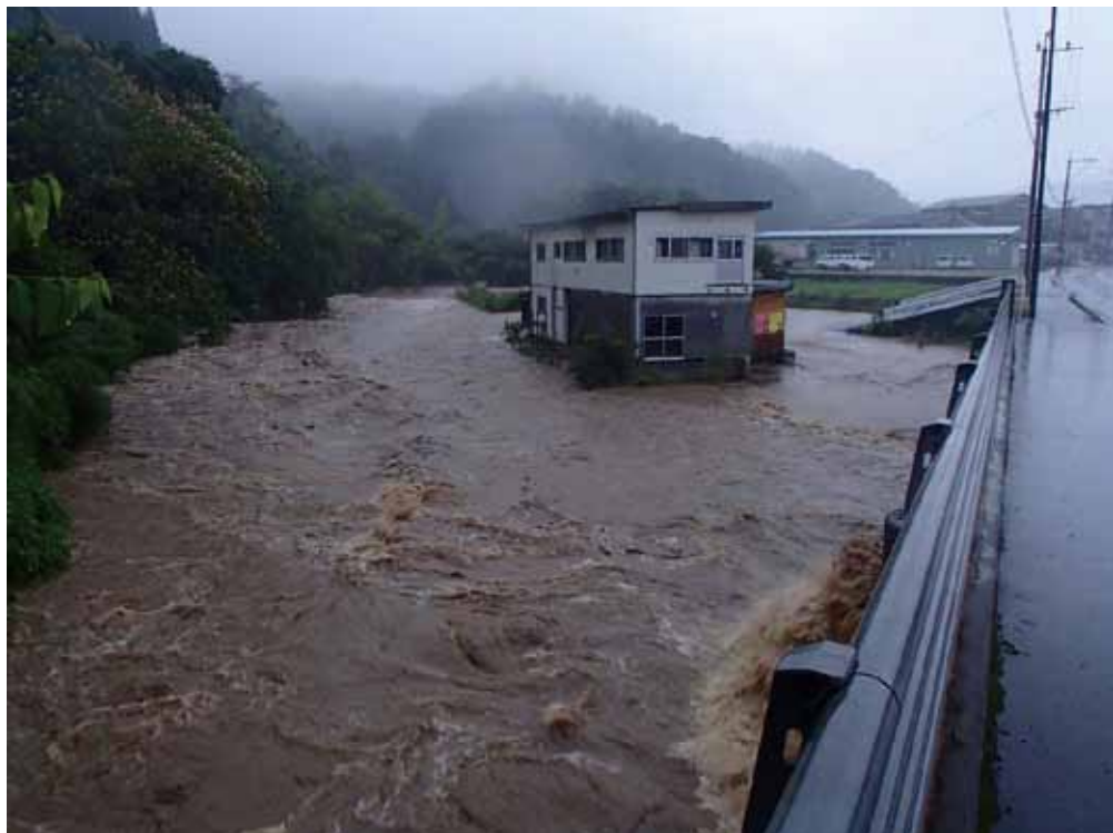
二串川出水状況（日田市大字友田）【九州北部豪雨】
