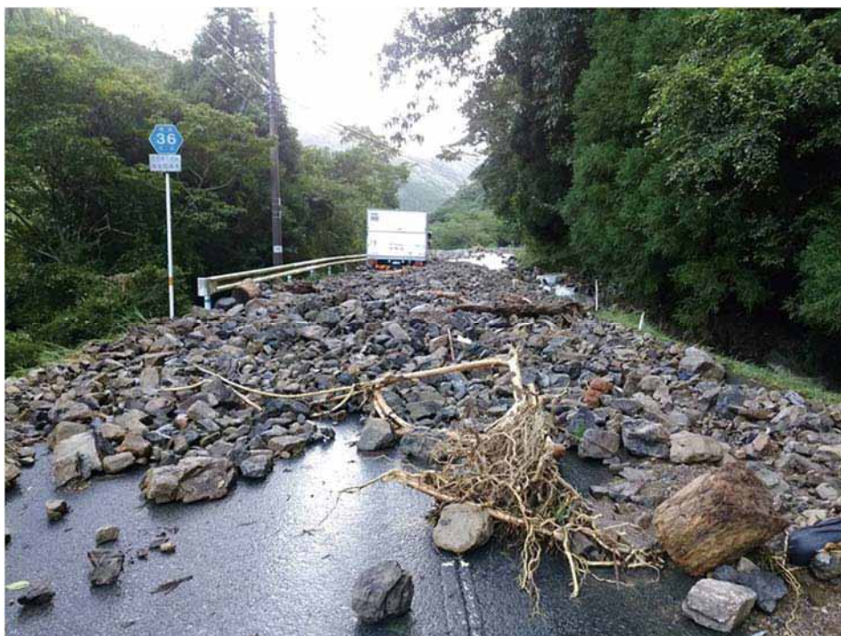
(主)佐伯津久見線被災状況（佐伯市弥生大字床木）【台風第18号】
