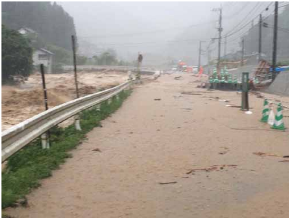
小野川浸水状況（日田市大字小野）【九州北部豪雨】
