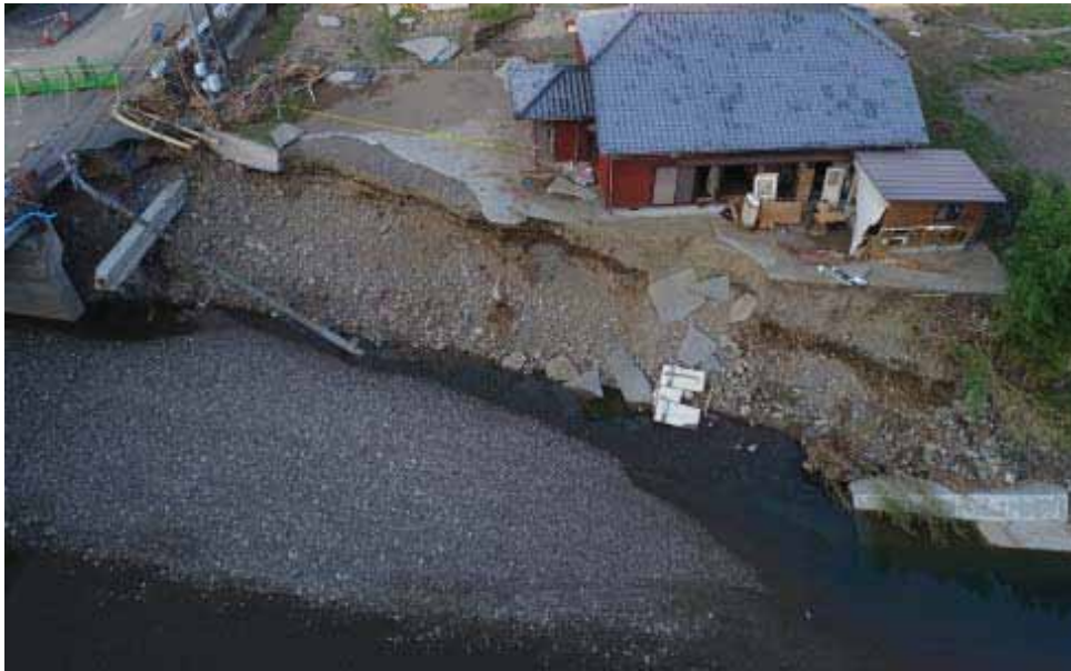
井崎川被災状況（佐伯市弥生大字大坂本）【台風第18号】
