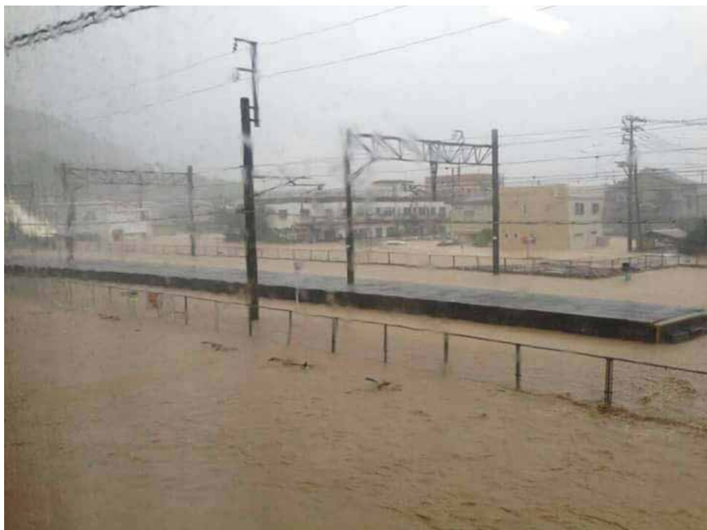
津久見市街地浸水状況（津久見駅）【台風第18号】
