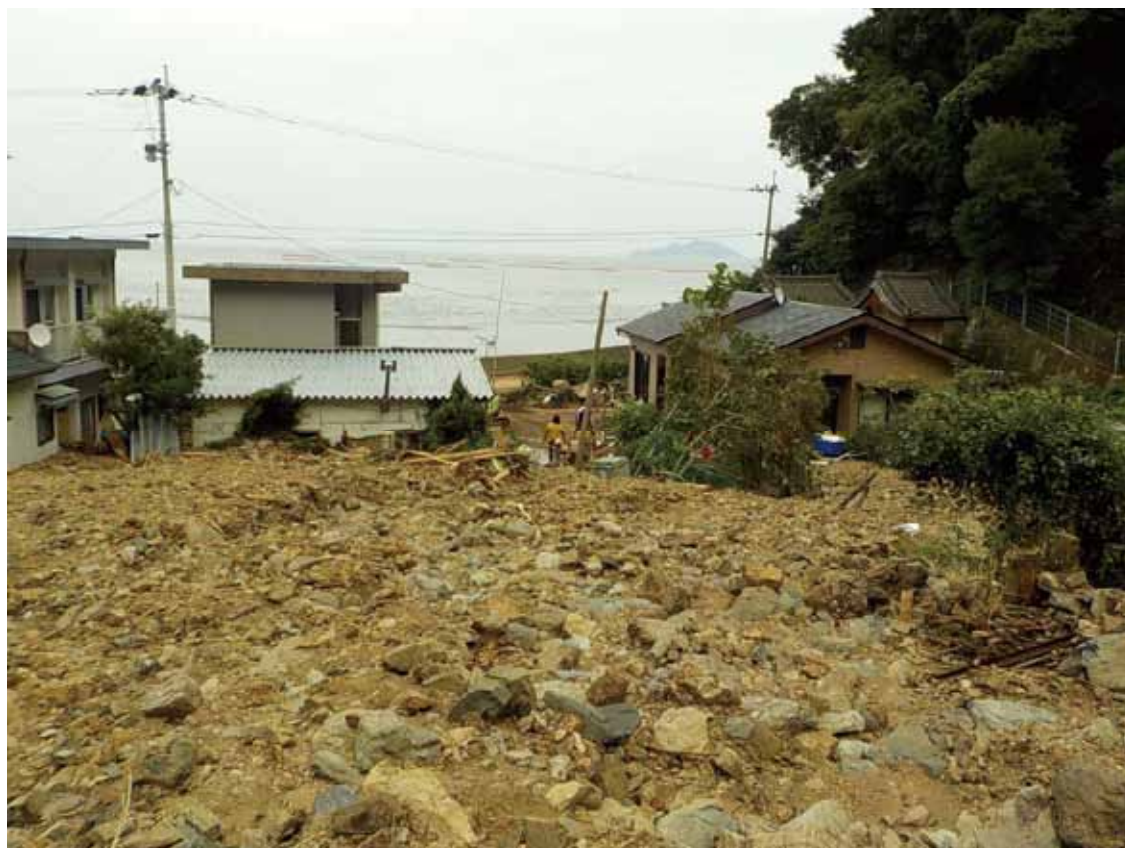
楠屋川土石流被災状況（津久見市大字長目）【台風第18号】
