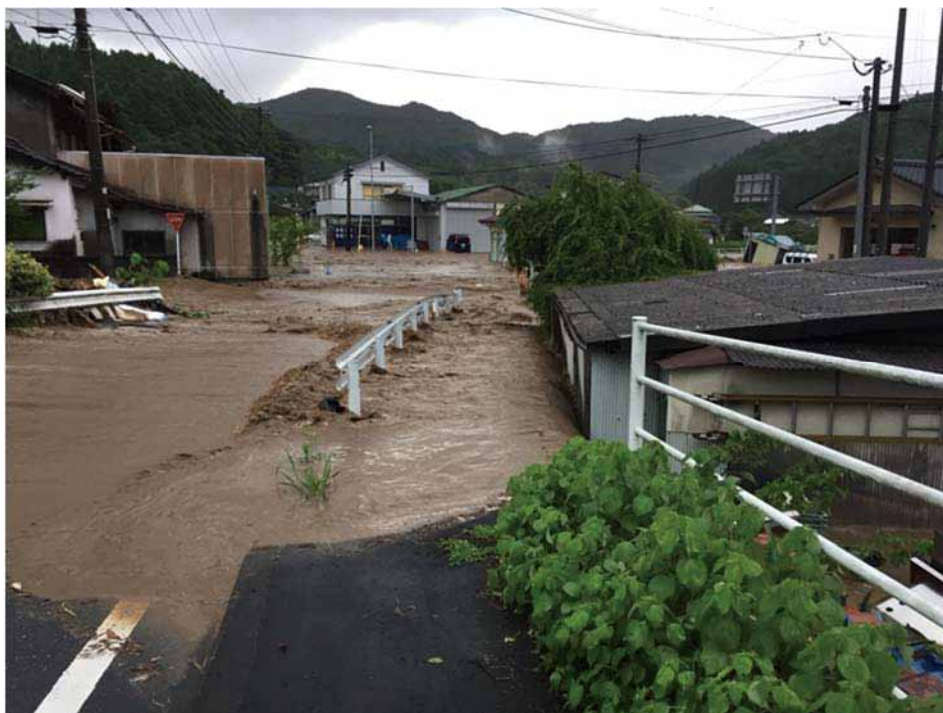
国道211号冠水状況（日田市大字大肥）【九州北部豪雨】
