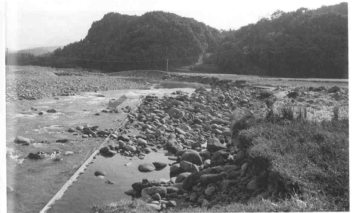
津房川 安心院町大字尾立 津房川護岸決壊による被害状況
