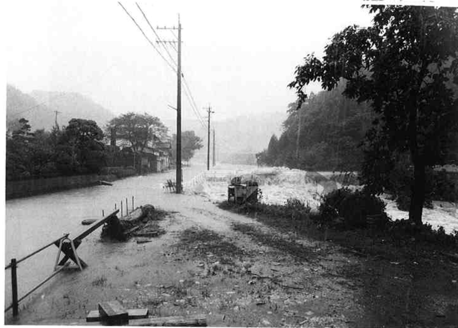
佐田川の増水による県道山香院内線の冠水
