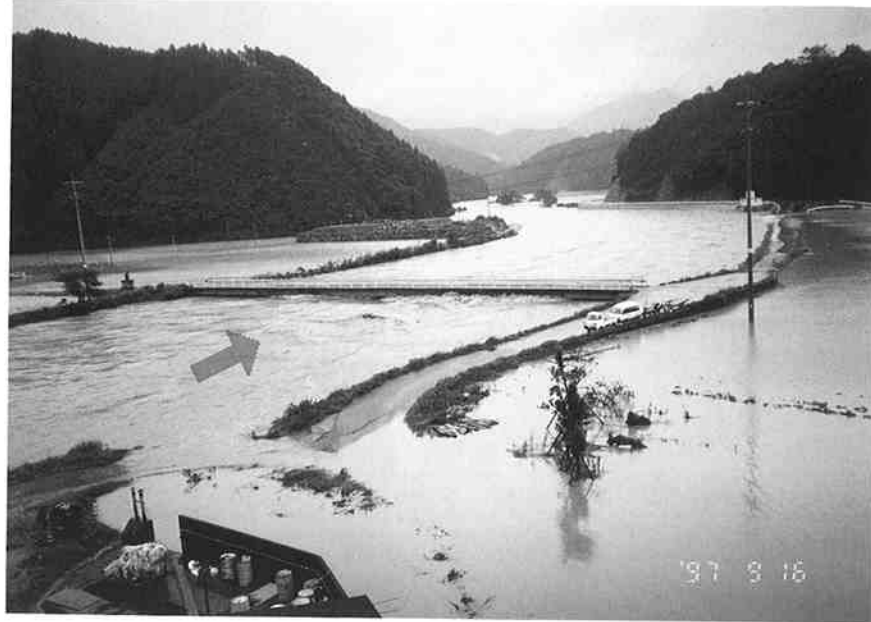
久留須川の増水による堤内の浸水
