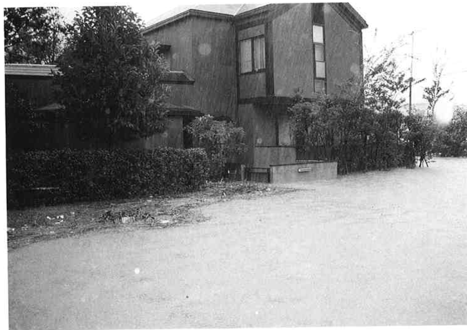
尼ヶ瀬川の増水による家屋の浸水
