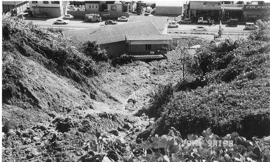
崖崩れによる住居家屋の倒壊
