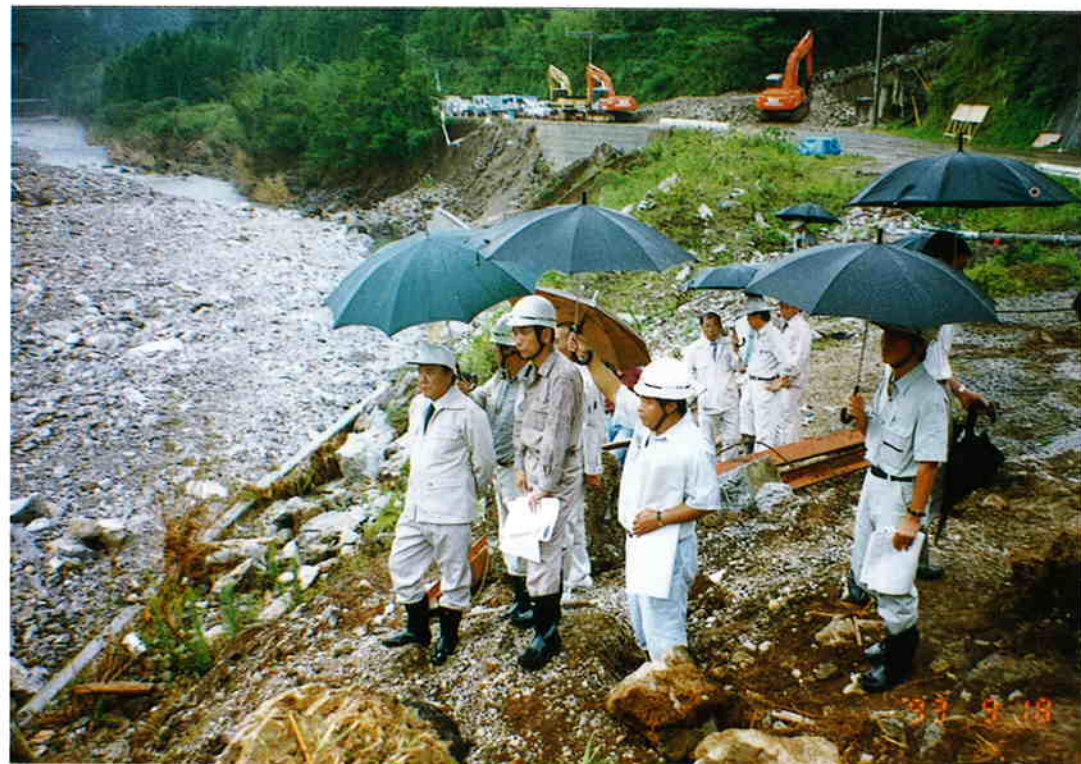
県道三重・弥生線（大規模地すべり）
