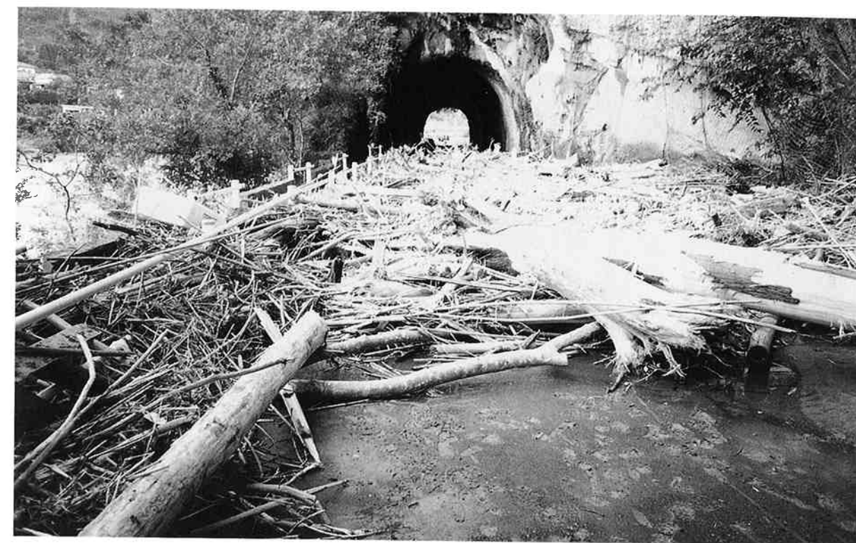
青の洞門トンネル前に堆積した流木（本耶馬溪町）
