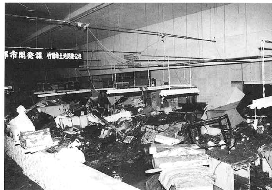
竹田市役所第2庁舎内の散乱
