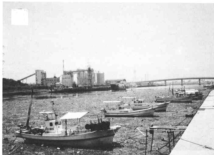
大分港鶴崎泊地の流木の滞留（大分港）
