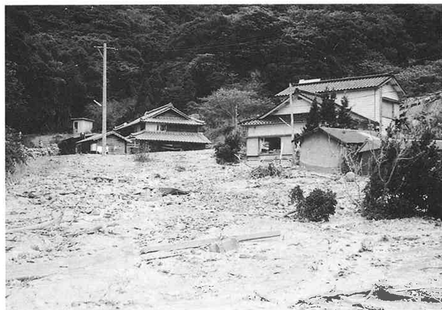
台風21号による崩壊土砂で埋没した家屋（鶴見町）
