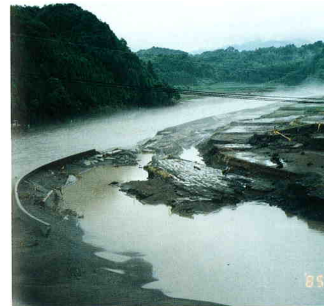
大野川大渡付近の護岸崩壊
