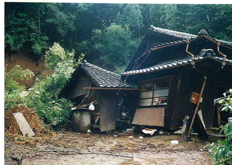
崖崩れにより傾いた民家（大野町）
