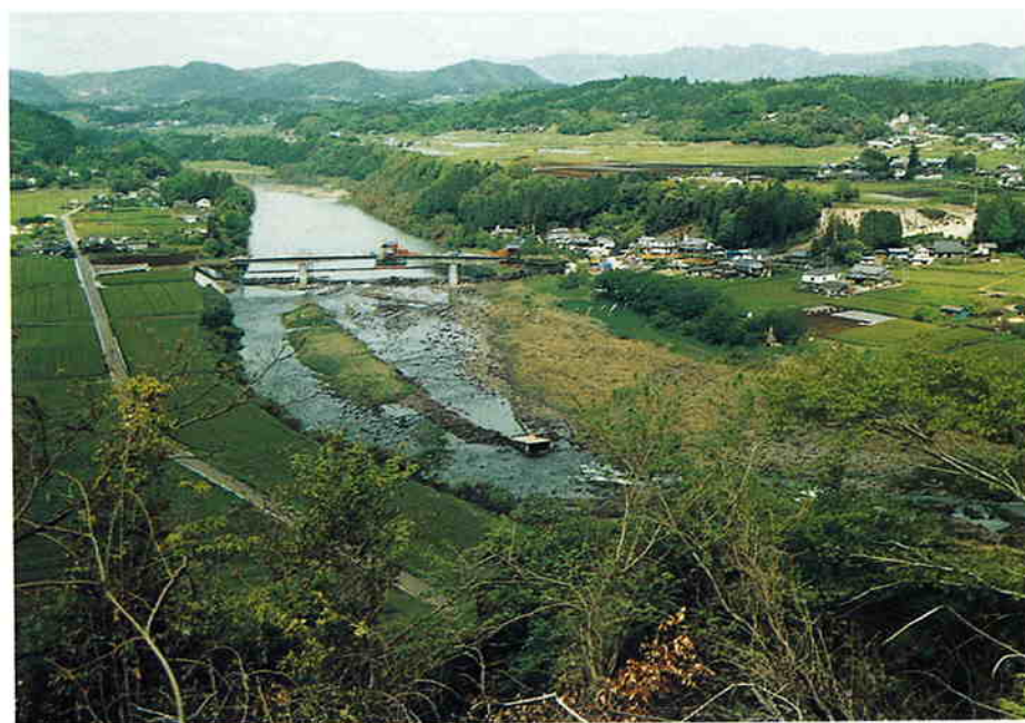
平成大橋の平常のすがた
