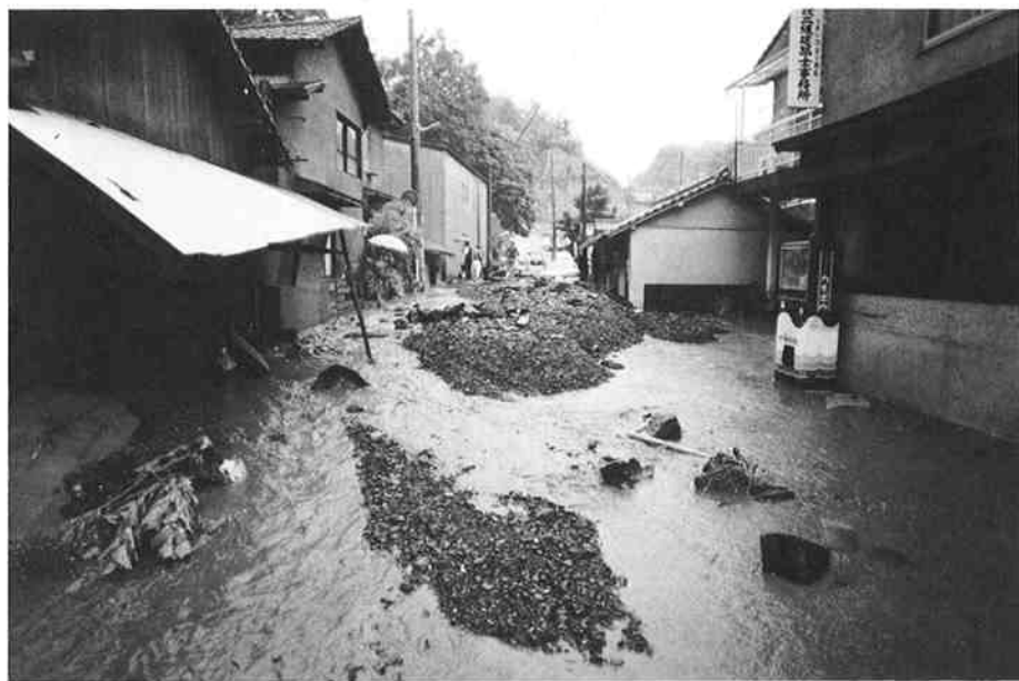
土石流で埋没した市街地（竹田市）
