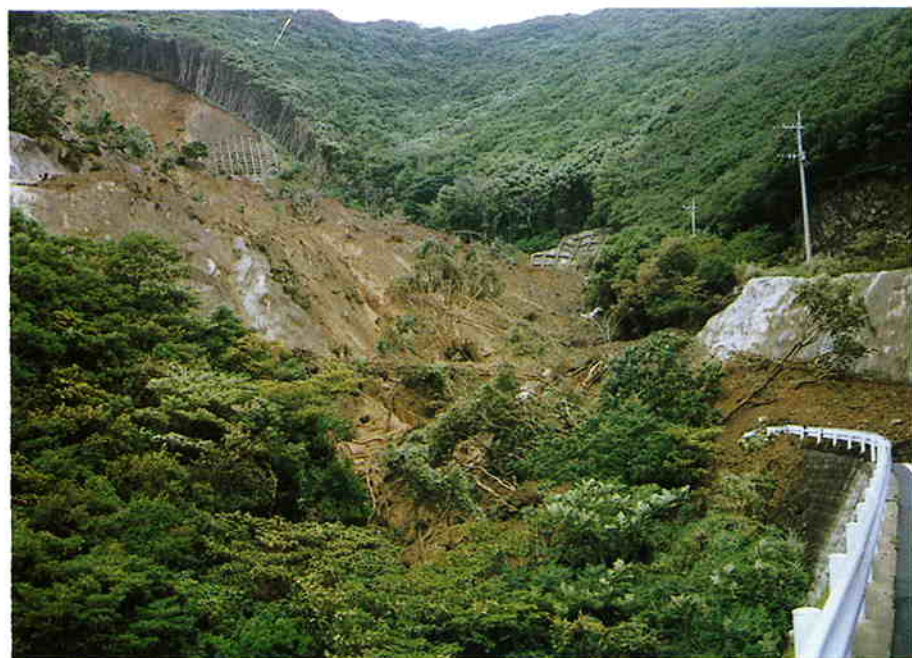
台風21号による町道梶寄鶴見線の法面崩壊（鶴見町）
