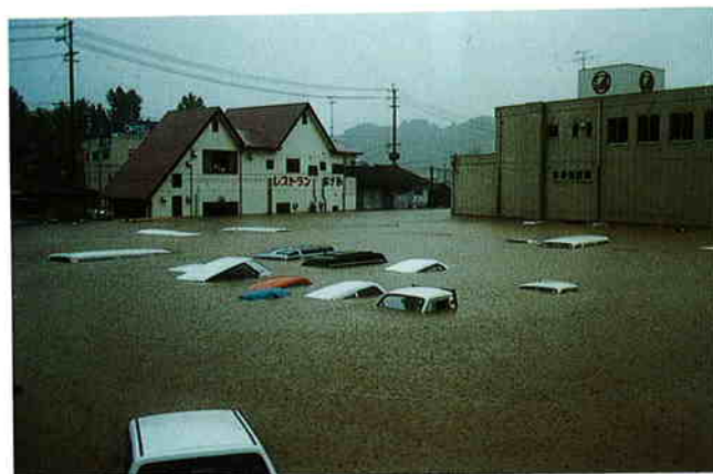
竹田駅前駐車場の浸水（竹田市）
