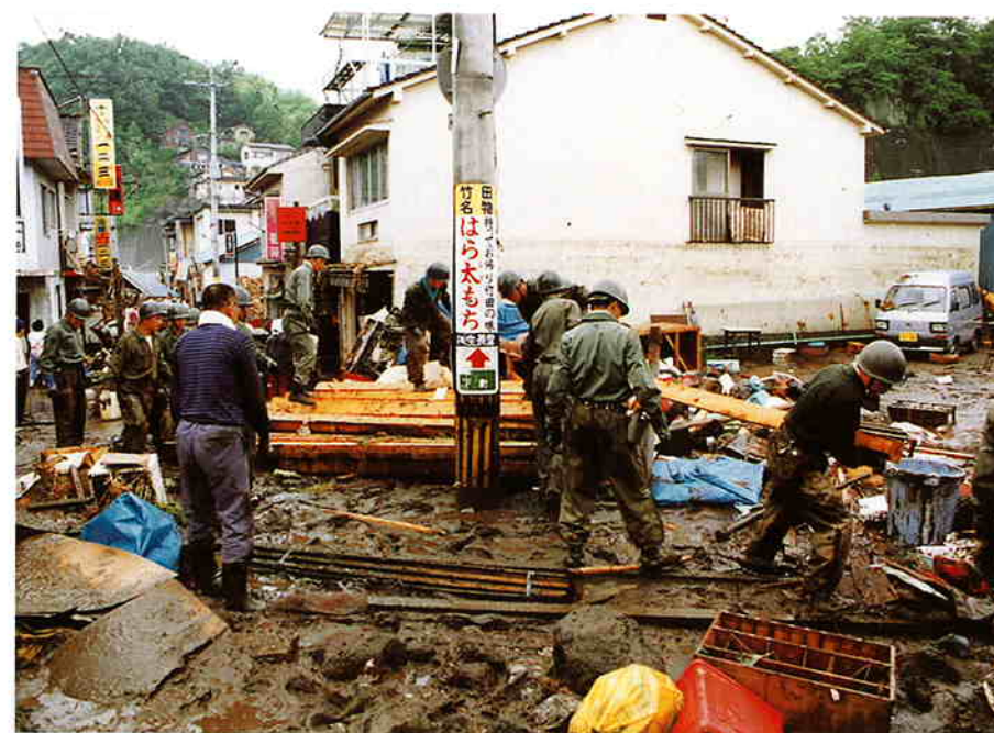
自衛隊による復旧作業（竹田市下町）
