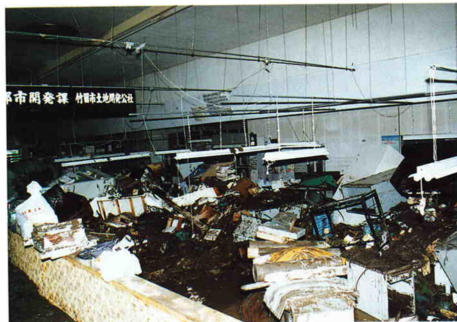
竹田市役所第2庁舎内の散乱
