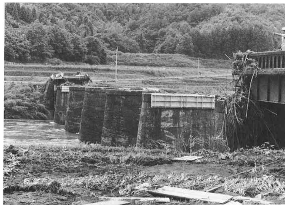
県道百枝大野線向野橋の流失（三重町）
