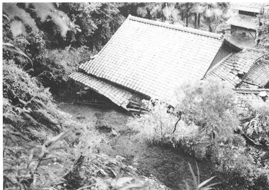
崖崩れにより埋没した家屋（大野町）
