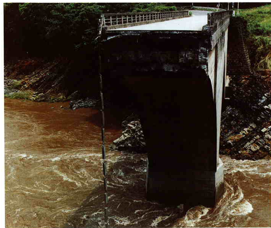
大野川大野橋の流失 大野町
