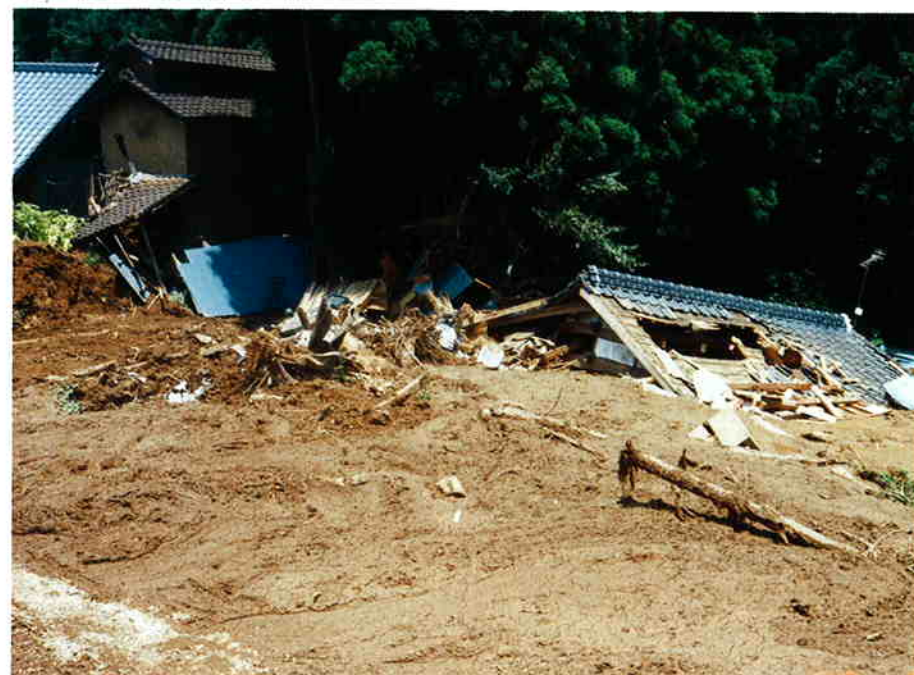
岩の上川の土石流により押しつぶされた家屋（大野町）
