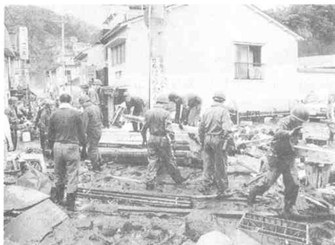
自衛隊による復旧作業（竹田市下町）
