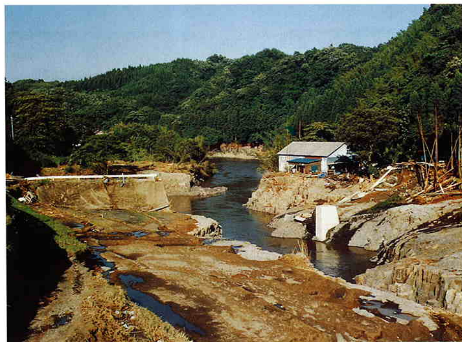
稲葉川魚住橋の流失（竹田市）
