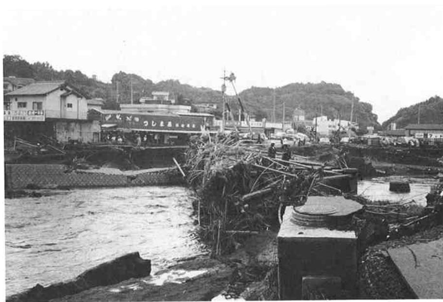
玉来川常磐橋付近の護岸決壊（竹田市）
