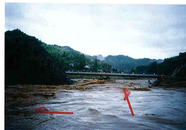
工事中の玉来川ショートカット部の流れ
