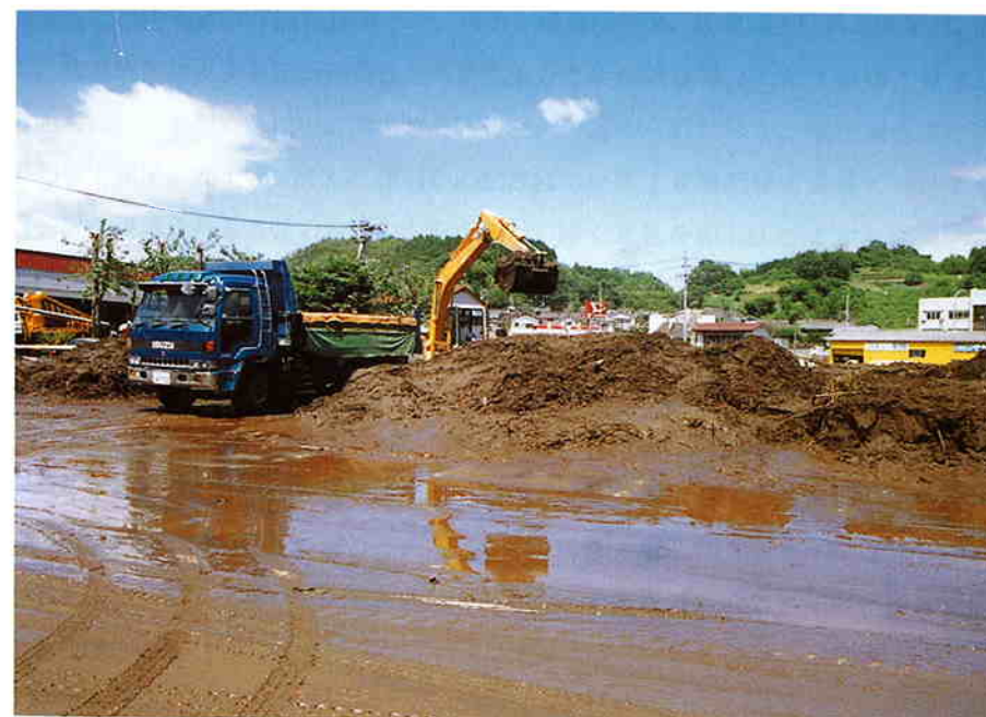
土砂排除作業（竹田市拝田原）
