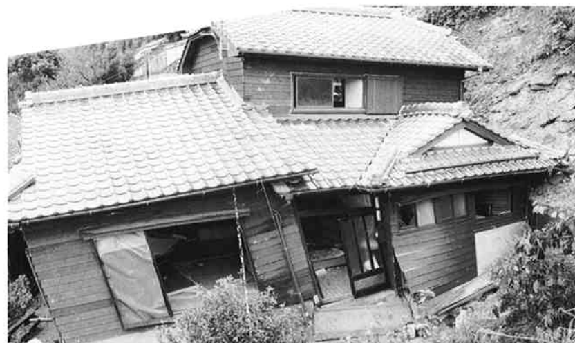
崖崩れにより傾いた家屋（蒲江町）
